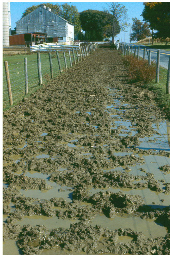
Figure 25. Exemple de chemin d'accès inacceptable
