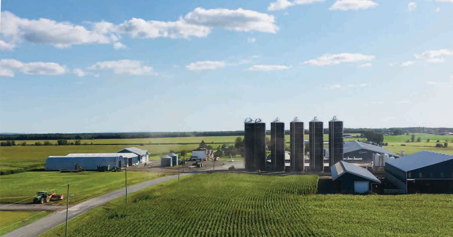
Le « vieux site de production » avec les bâtiments d'élevage ainsi que les entrepôts et l'atelier.
